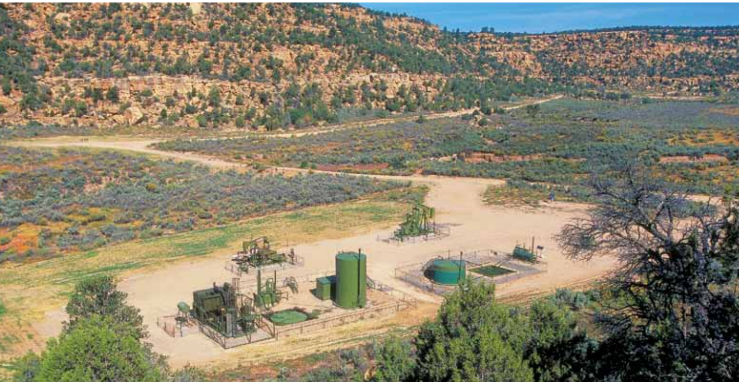
Lokasi sumur di San Juan Basin, New Mexico, menunjukkan fasilitas kompresor gas alam dan baterai tangki.
