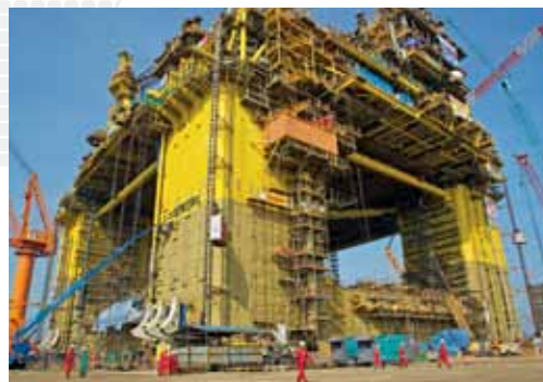
Продолжаются строительные-монтажные работы на месторождении Гумусут, где в конце 2013 года ожидается ввод в эксплуатацию плавучей нефтедобывающей платформы
