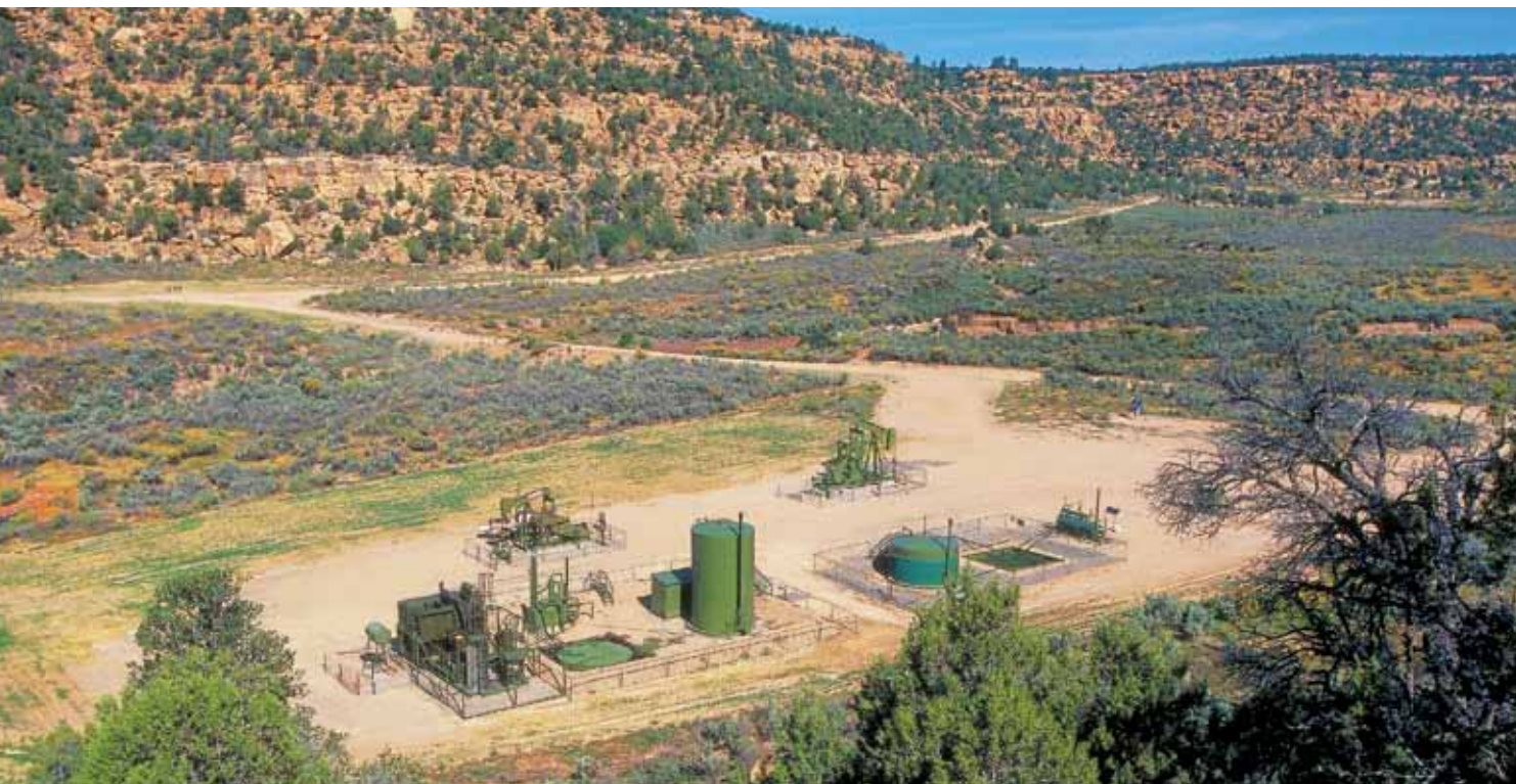
Буровая площадка в бассейне Сан-Хуан в штате Нью-Мексико; типовой газовый компрессор и резервуарный парк.
