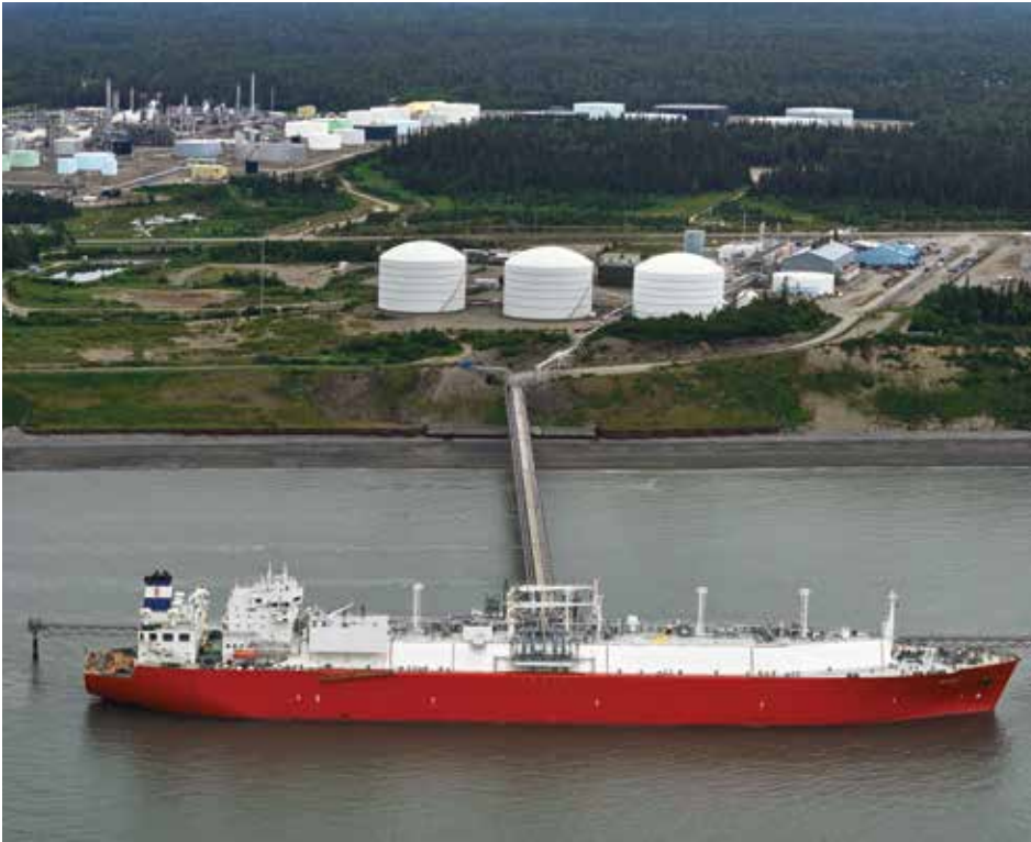
Kenai LNG Facility in Cook Inlet.
